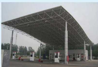
图1-14 加油站顶棚的网架结构
