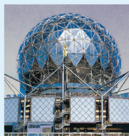
图1-15 某建筑的网壳结构
